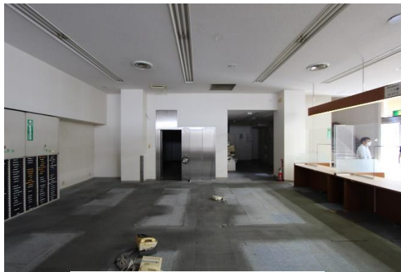
②1階 事務スペース
