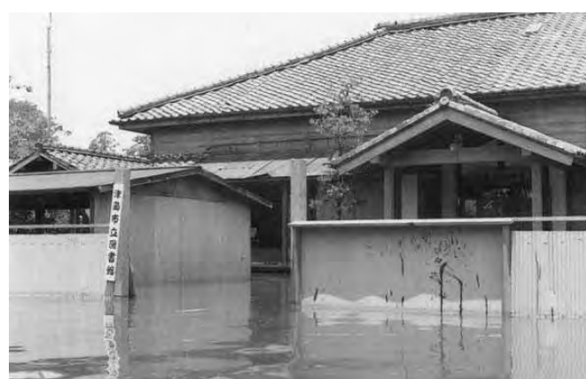
▲昭和36年集中豪雨、津島市立津島図書館
